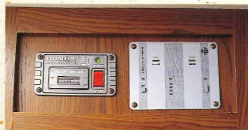
ジェネレータースイッチ&LP/COアラームモニター
