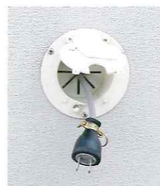
■ACケーブルハッチ
